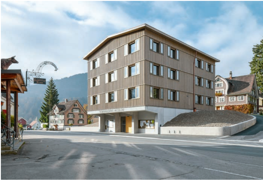
Giebelständig wie die anderen Häuser steht das neue Gemeindehaus an der Hauptstrasse in Nesslau.
