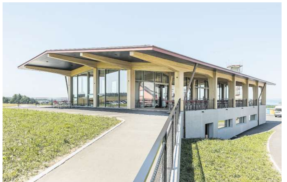
Das Gemeinschaftshaus und Gastrogebäude des Ekkarthofs in Lengwil. Auf den steinernen Sockel setzte Architekt Lukas Imhof eine Konstruktion aus Eschenholz, ausgefacht mit Glas.
