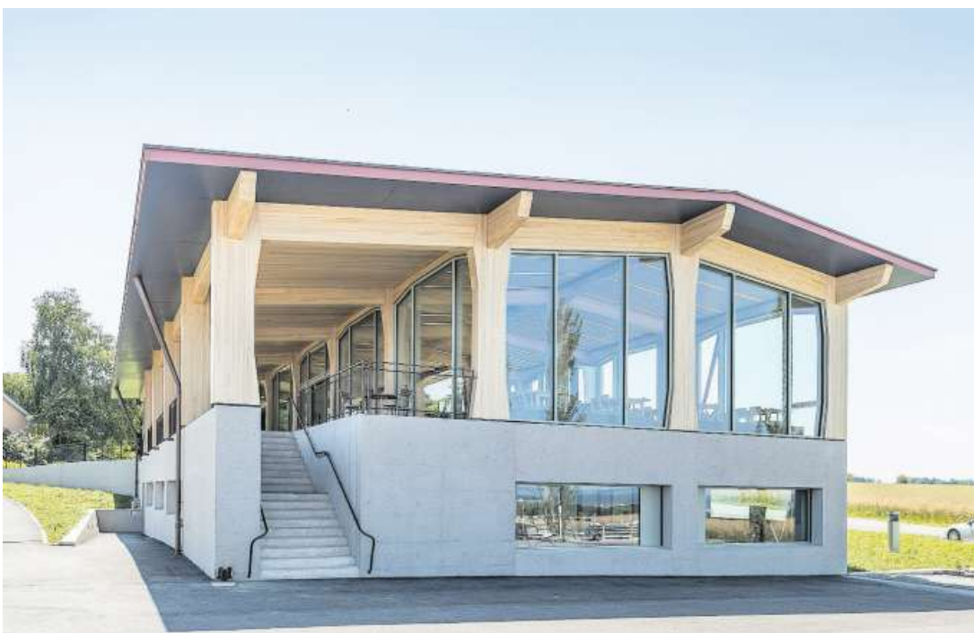
Das Gemeinschaftshaus und Gastrogebäude des Ekkarthofs in Lengwil. Auf den steinernen Sockel setzte Architekt Lukas Imhof eine Konstruktion aus Eschenholz, ausgefacht mit Glas.
